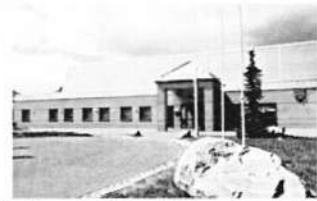
Sport- und Mehrzweckhalle
